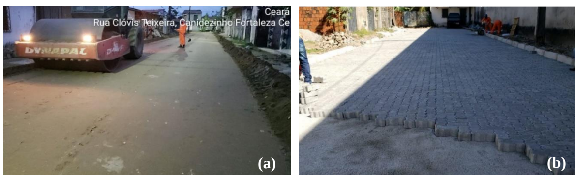
Figura 4: (a) Execução de sub-base e (b) aplicação de camada de assentamento e intertravado
