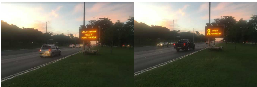
Figura 5: Painéis de mensagens variáveis no trecho da rodovia DF-002
