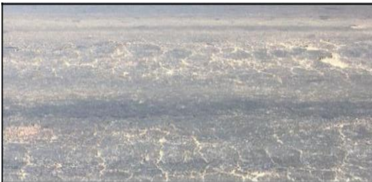
Figura 4: Fendas Transversais e Pele de Crocodilo
