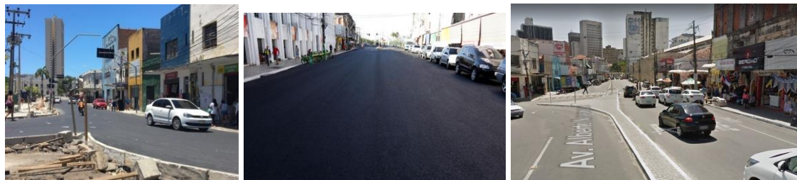
Figura 6: Aspecto da via após execução
