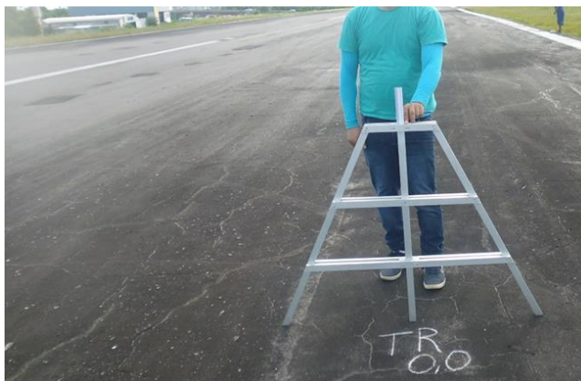
Figura 1: Aspecto geral da PPD.
